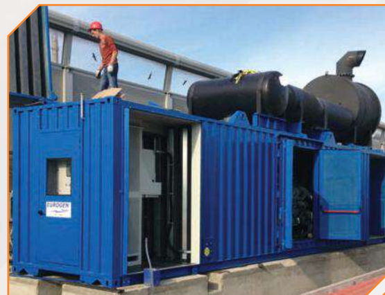
SNODO FERROVIARIO BOLOGNA ALTA
