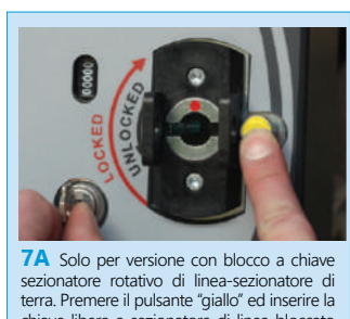
5 Sezionamento (rotazione)
