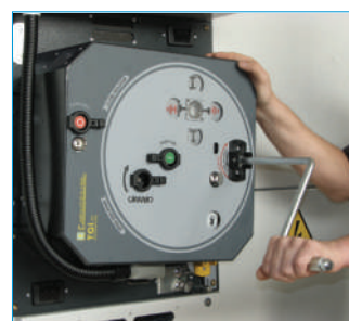
6 Sblocco del sezionatore di linea
