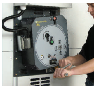
8 Blocco del sezionatore in chiuso
