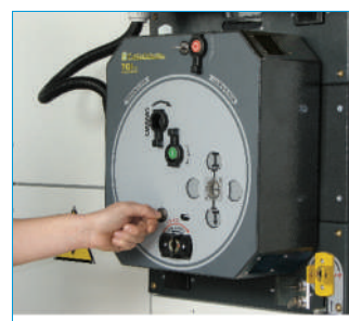
9 Blocco a chiave del sezionatore in chiuso (se previsto)
