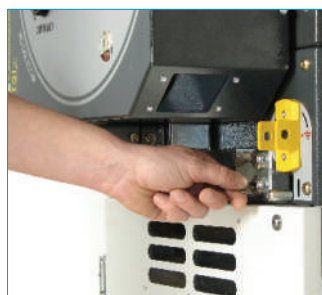
2 Sblocco a chiave del sezionatore di terra ST in chiuso (se previsto)
